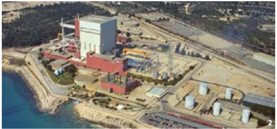
1. Obras de desmantelamiento de la central. FOTO: ENRESA.
