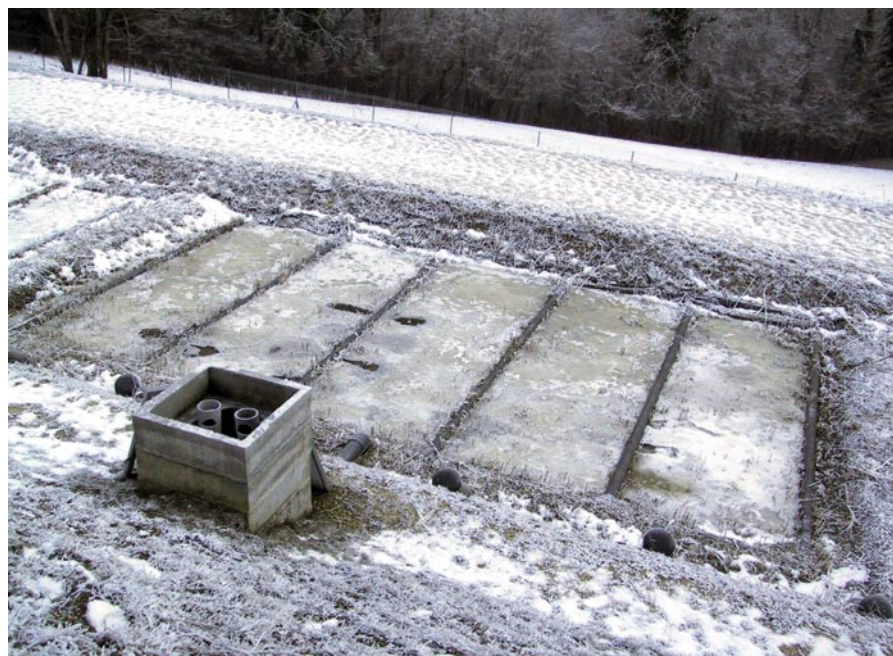
Station d'Allèves. Deuxième étage de filtration en période hivernale. On distingue le regard de répartition à l'avant-plan et un casier au repos avec les canalisations de distribution en surface du filtre.
