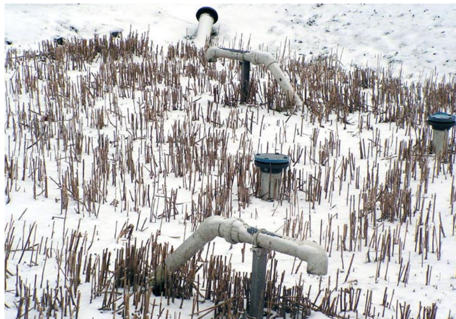
Station d'épuration d'Aulon dans les Hautes Pyrénées Casier au repos du premier étage.
