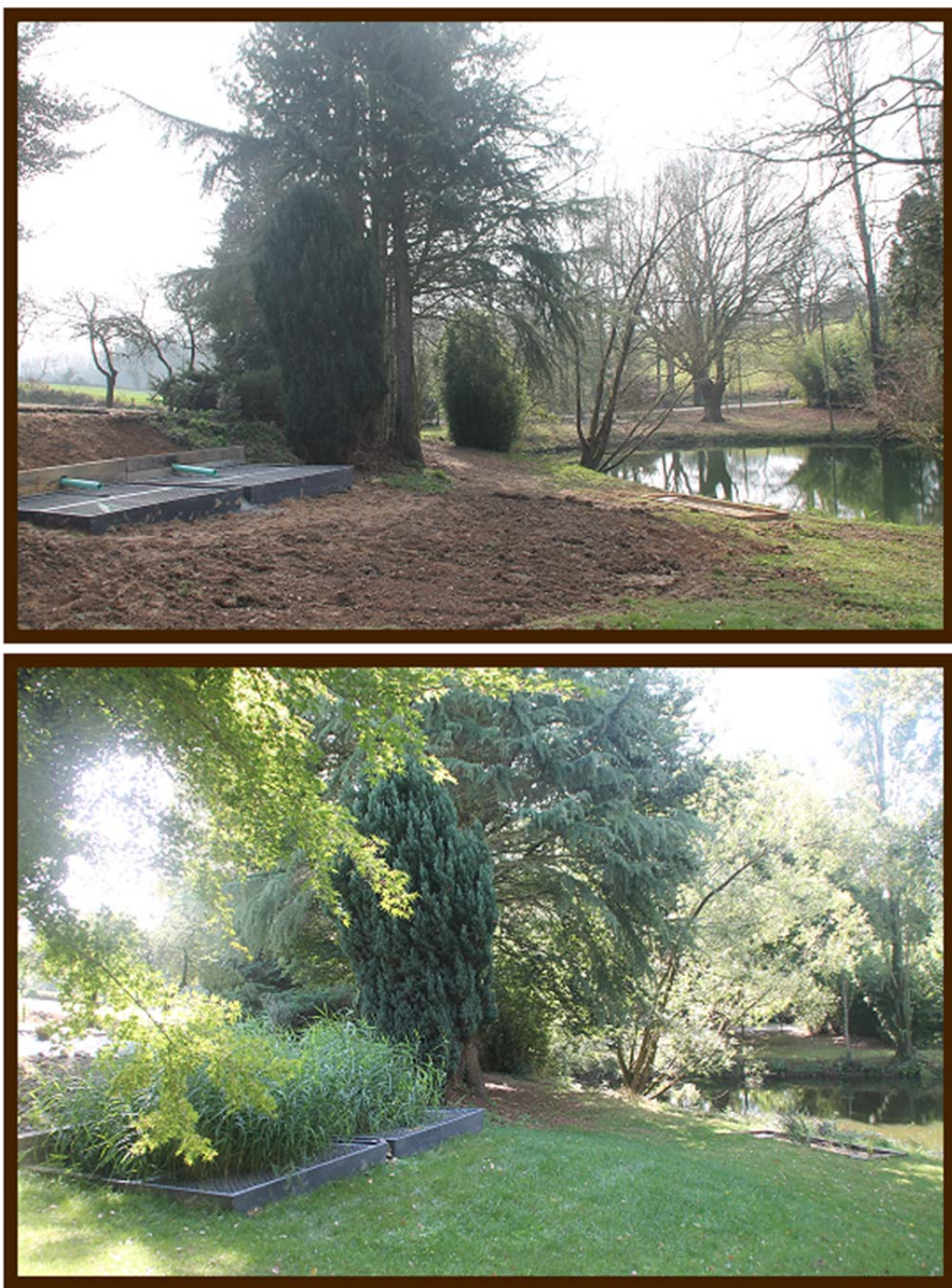
Imatge 3 Exemple d'implantació domèstic i evolució en un any d'un petit sistema de depuració a través de filtració vertical de macròfits. Font Aquatiris.fr.
