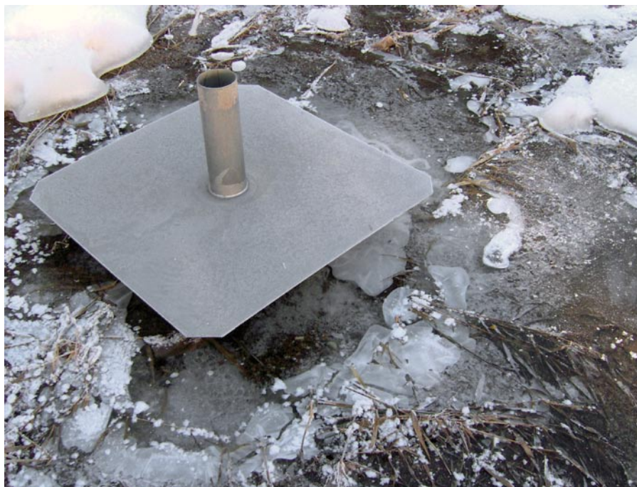
Station du Reposoir. Prise en gel du filtre primaire en période de repos. Le gel est accentué par la disparition du manteau de neige, fondu par les eaux brutes en période d'alimentation du casier.
