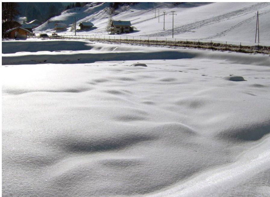
Station du Reposoir. Un casier du filtre primaire en période de repos. La couverture de neige réduit le risque de gel.
