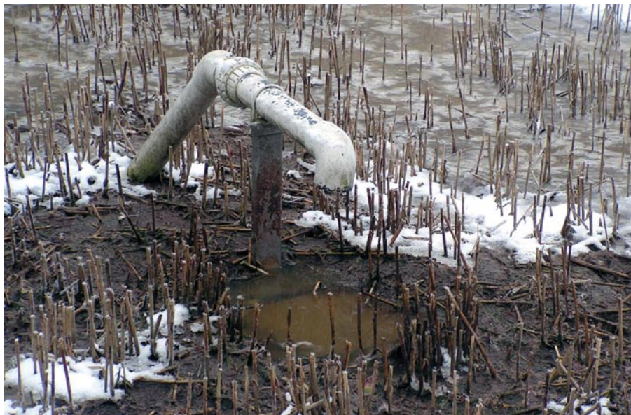
Station d'épuration d'Aulon dans les Hautes Pyrénées. Casier en service du premier étage.
