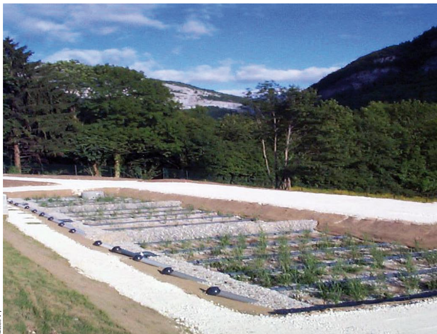
Station d'Allèves. Deuxième étage de filtration à la mise en service. Vue d'ensemble.
