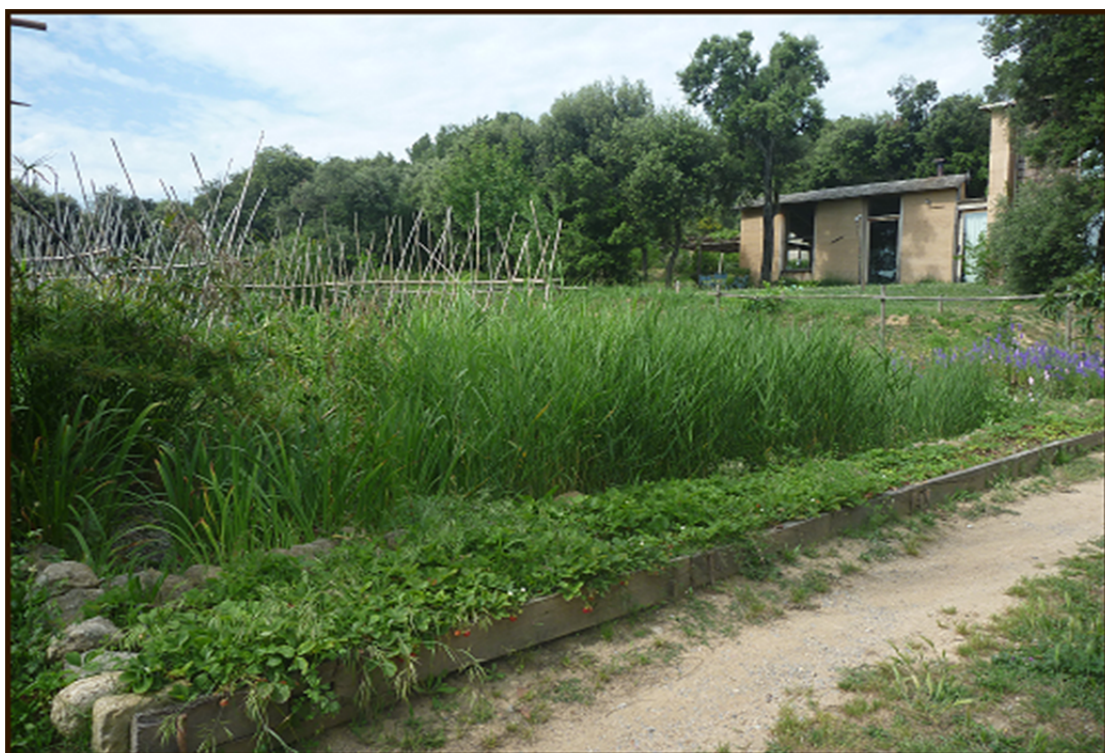
Imatge 2. Exemple de depuració horitzontal. Font Projectes d'Aigua
