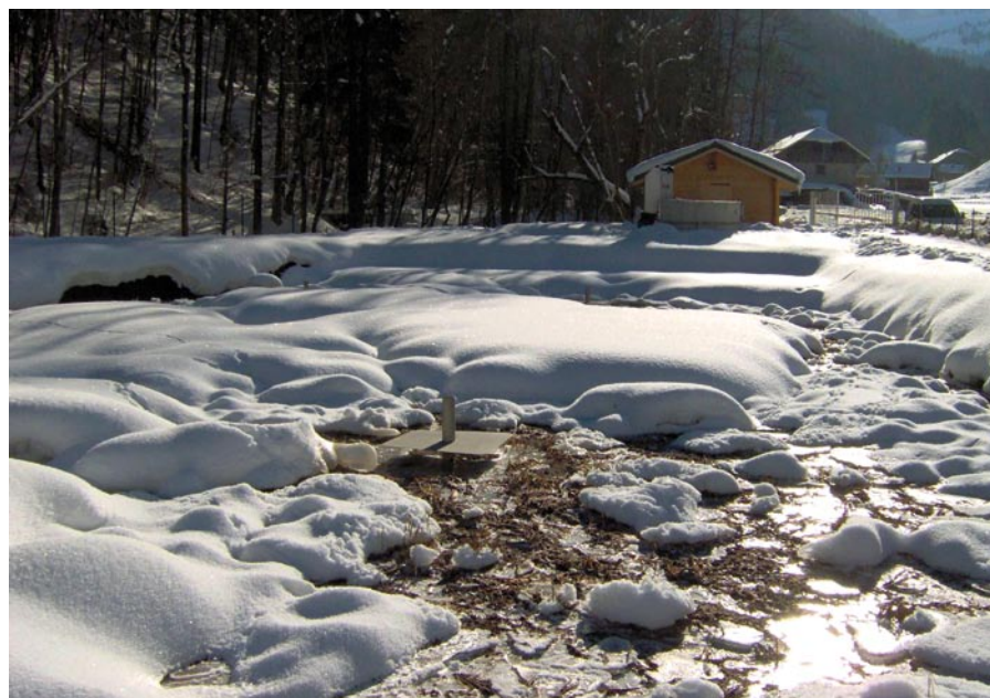
Station du Reposoir. Vue d'ensemble du filtre primaire en période hivernale. La chaleur des eaux brutes détruit le manteau de neige autour des points de distribution et favorise la formation de glace en surface du filtre.
